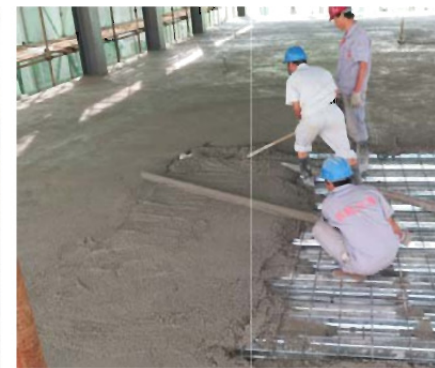
B型轻质垫层地面施工
