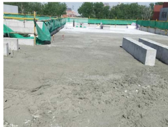
E型轻质垫层施工
