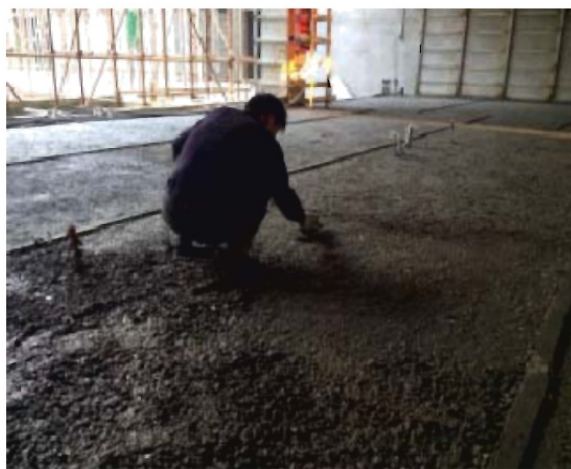
A型轻质垫层地面施工
