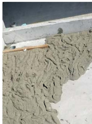
E型轻质垫层施工
