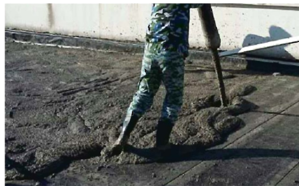
B型轻质垫层屋面施工
