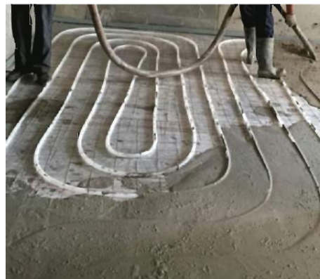
低温热水采暖垫层施工
