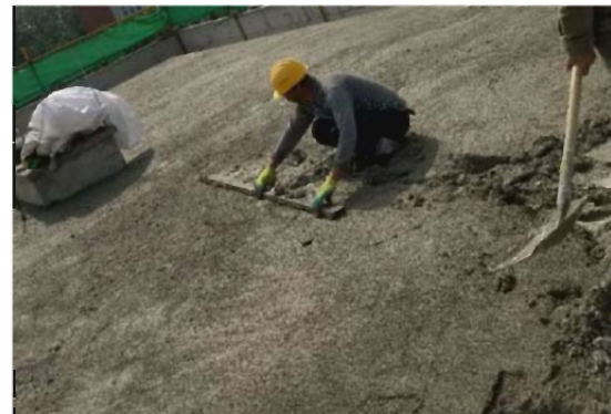
E型轻质垫层施工
