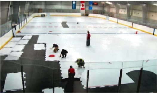
耐磨聚乙烯仿真冰面施工实例
